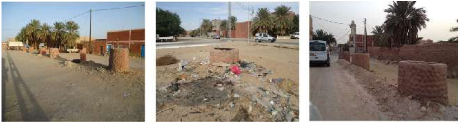
Figure 3 : Les puits des foggaras en milieu des centres urbains : dégradation et disparition progressive à Adrar
