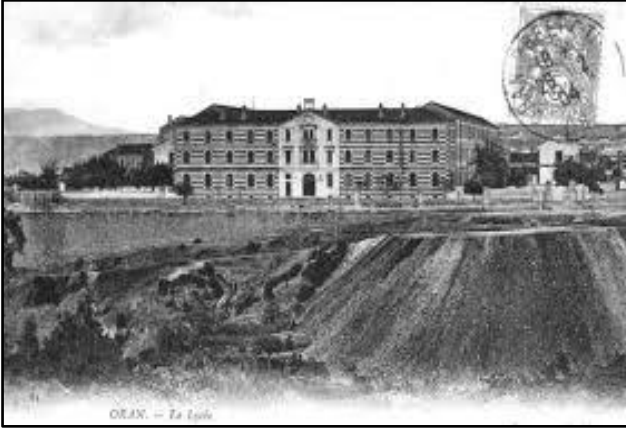
Fig. 9 : Comblement de ravins à Oran, durant la période coloniale
