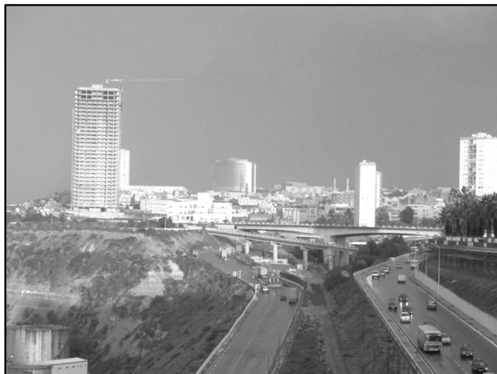
Fig. 11 : Pont traversant le Ravin Blanc (Début 21 ème s.)
