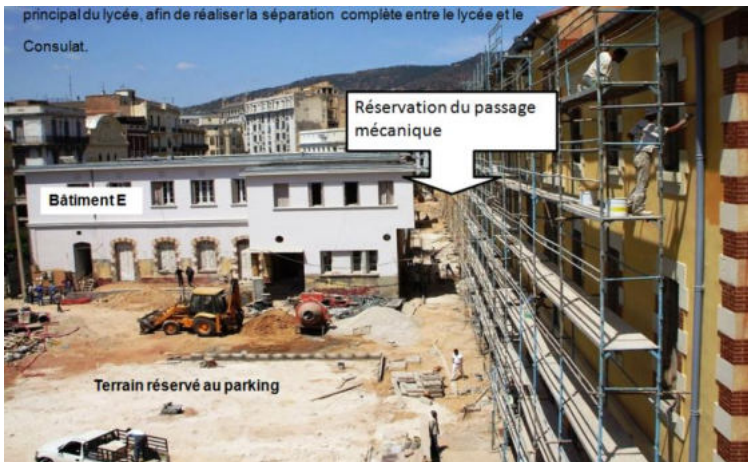
Figure 20 : Vue à partir de la terrasse du bâtiment neuf 2 (bloc logements). La séparation complète entre le lycée et le Consulat.
