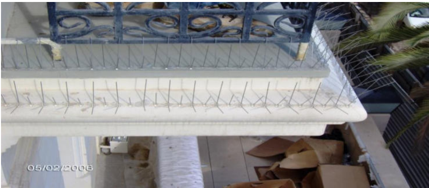
Figure 7 : Détail de la fixation de l'anti-pigeon aux abords du balcon.
