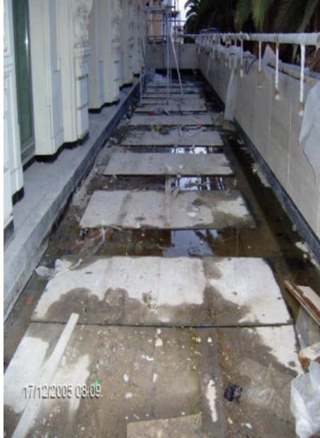
Figure 8 : La mise en place des panneaux de calfeutrement avant la pose des revêtements en pierres sur la terrasse de la pâtisserie.
