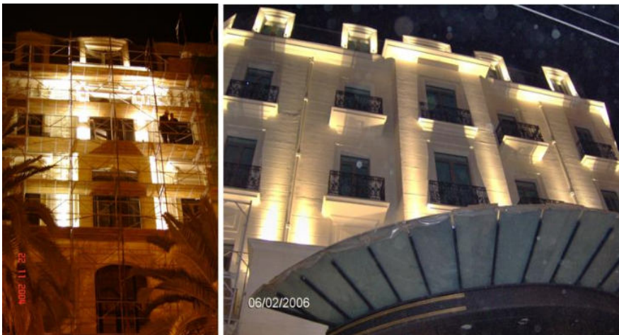
Figure 11 : Vue sur la façade du bâtiment. Après plusieurs essais sur les formes d'éclairages, utilisation de la signalétique pour la valorisation du bâtiment.
