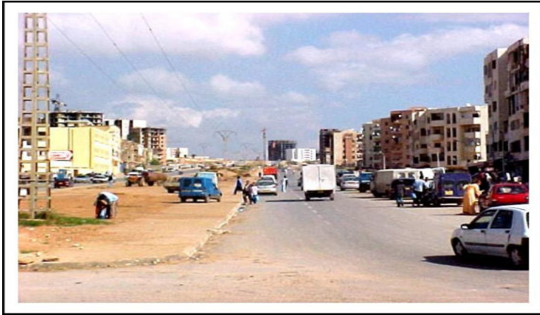
Figure 4 : Le boulevard longeant le POS 52. Une voie qui présente un danger à la population et une rupture dans le tissu urbain
